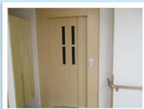
車椅子も入るエレベーター
